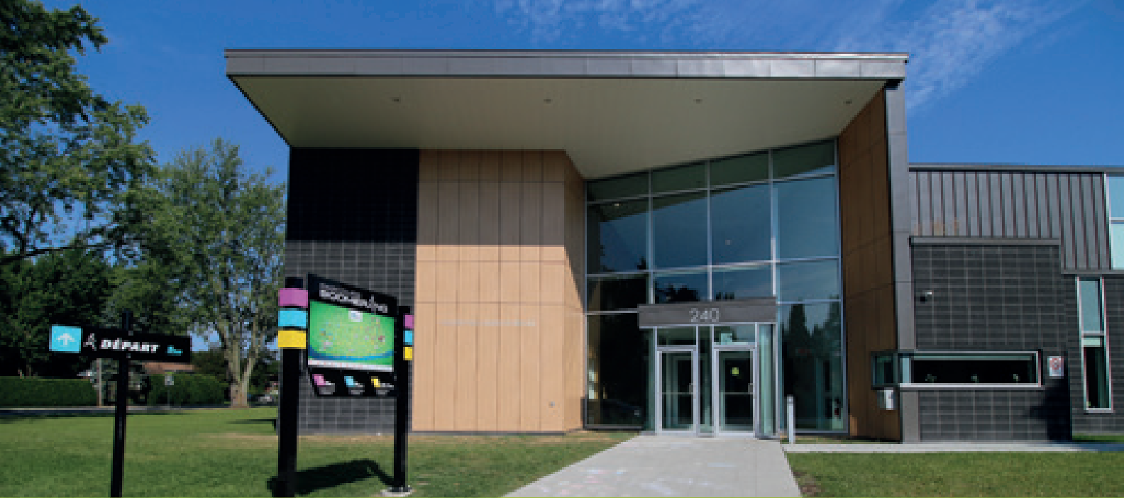
Le nouveau Centre des loisirs de Belœil
